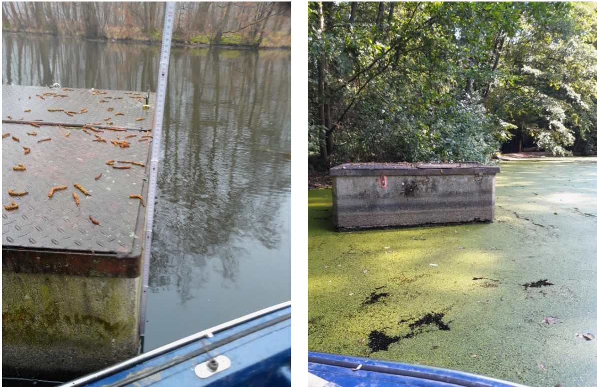
Abbildung 25: Messung des Wasserstands am Ablassbauwerk (Mönch) des Engelmannteichs im März 2024 (links). Blick auf den Mönch im Sommer (rechts).
